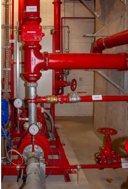
Die Sprinkleranlage im Untergeschoss mit Wasserbehälter aus wasserundurchlässigem Beton im Hintergrund.
